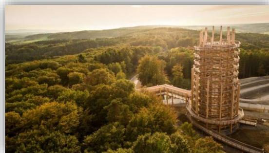
Zum Park gehört ein 1635 Meter langer Baumwipfelpfad in bis zu 23 Metern Höhe und ein Aussichtsturm. Dieser insgesamt 40 Meter hohe Aussichtsturm verfügt über eine Aussichtsplattform in 34 Metern Höhe. Verbaut wurden insgesamt 700 Kubikmeter Holz.
